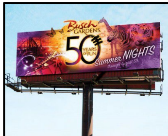
CENTER MONOPOLE V FACE
